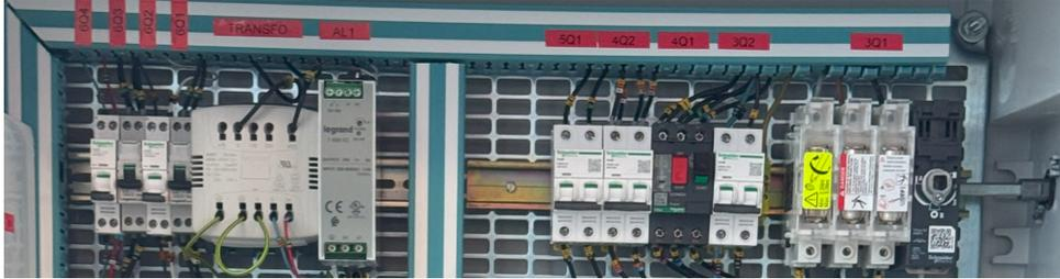
FIGURE 6.1 – Disjoncteurs de l'armoire
