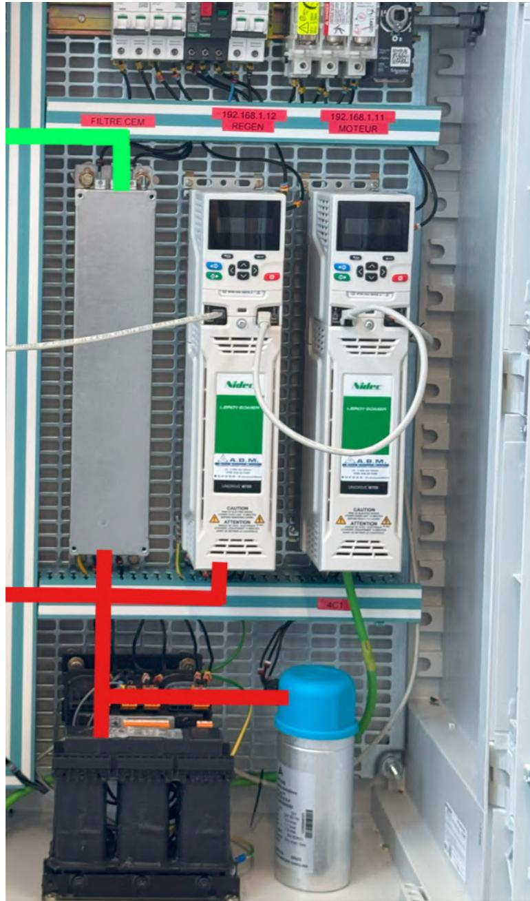
FIGURE 6.3 – Circuit de câblage du filtre CEM
